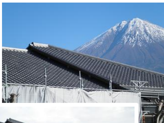
きれいに改修された屋根
